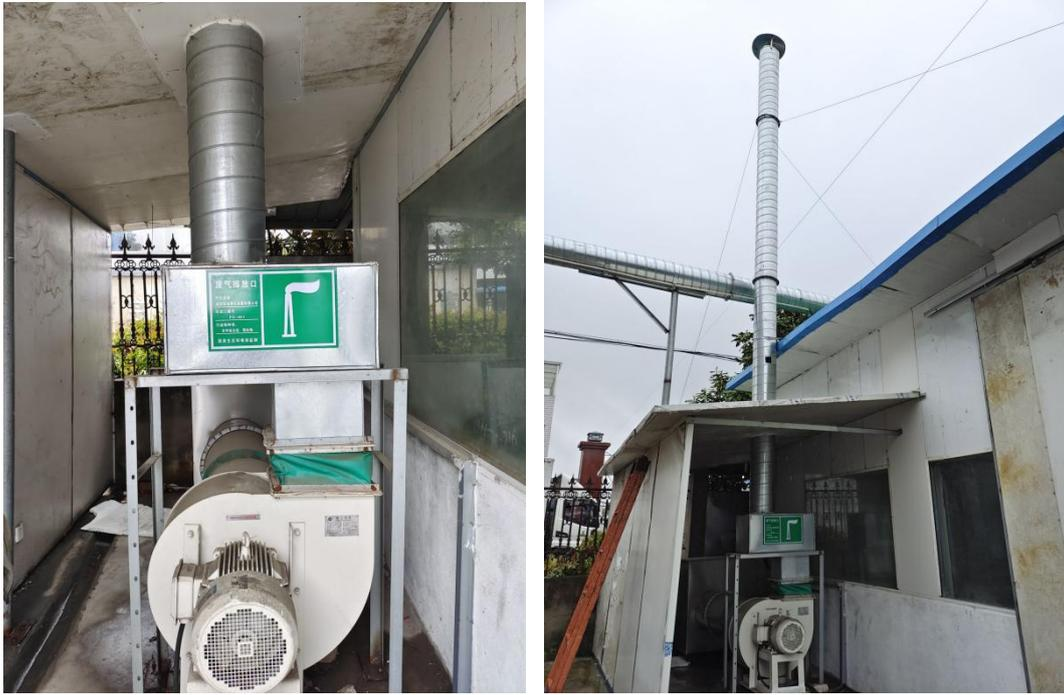
图 2-4 涂胶和固化工序废气处理设施 1#排气筒
